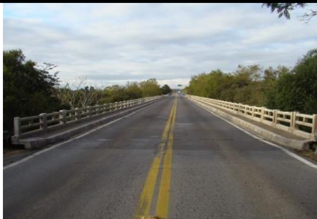
Vista superior, sentido Camaquã / Pelotas
