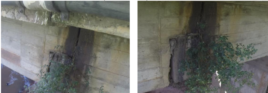
Dentes Gerber próximo ao apoio P7 – Lado direito
