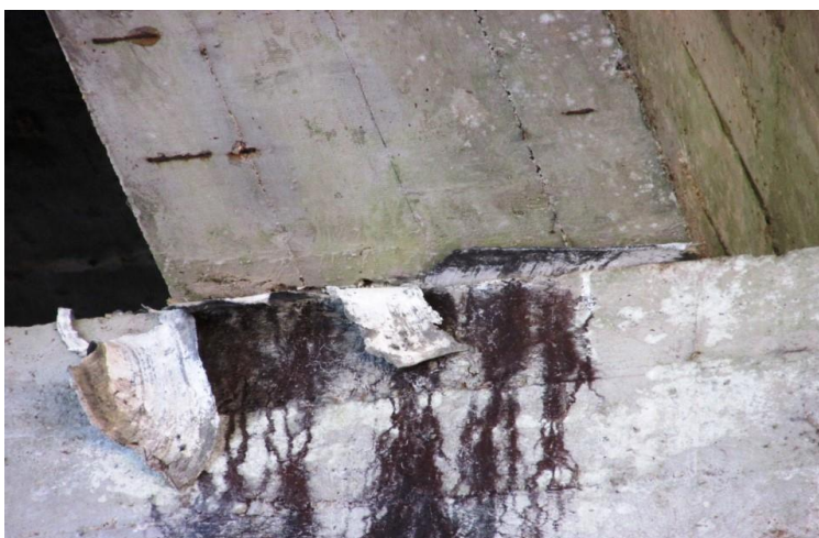
Idem foto anterior, em visão do aparelho de apoio (AA.8), locado sobre a viga travessa da linha de apoio 03, sob a viga longitudinal VL.02.
