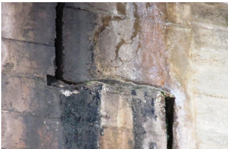
Idem foto anterior, porém, em visão aproximada do aparelho de apoio em articulação de chumbo, entre os dentes Gerber dos tabuleiros 03 e o tabuleiro bi apoiado (suspensão) 02 – lado Leste da OAE.
