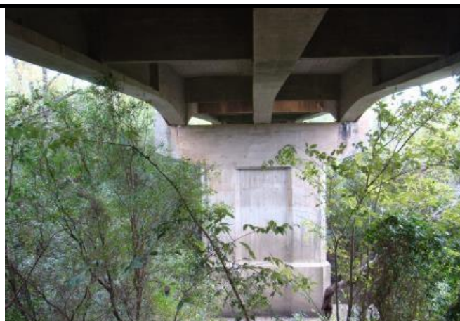
Vista inferior sentido Camaquã / Pelotas
