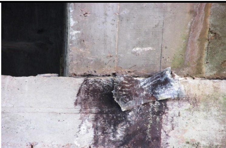
Enfoque do aparelho de apoio (AA.7), já com ruptura do material, locado sobre a viga travessa da linha de apoio 03, sob a viga longitudinal VL.01.
