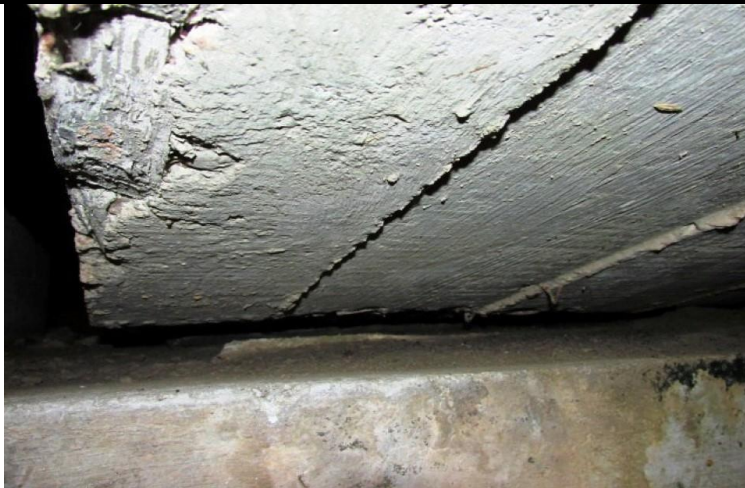
Vista do aparelho de apoio em neoprene (AA.24), com o elastômero íntegro.
