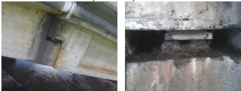
Dentes Gerber próximo ao apoio P6 – Lado direito
